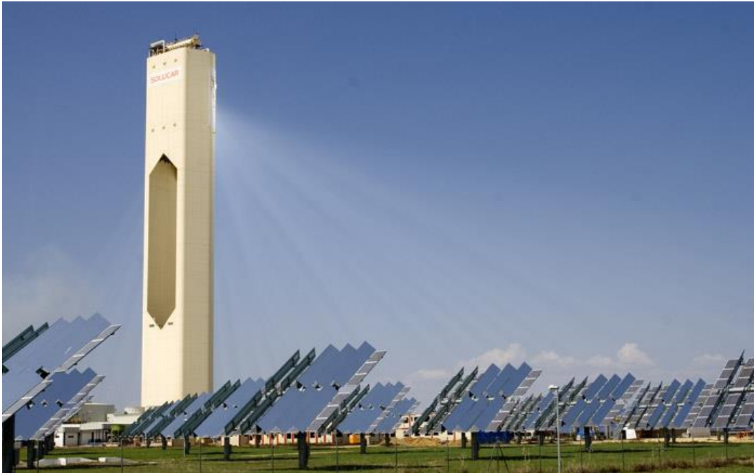
Centrale solare a specchi
