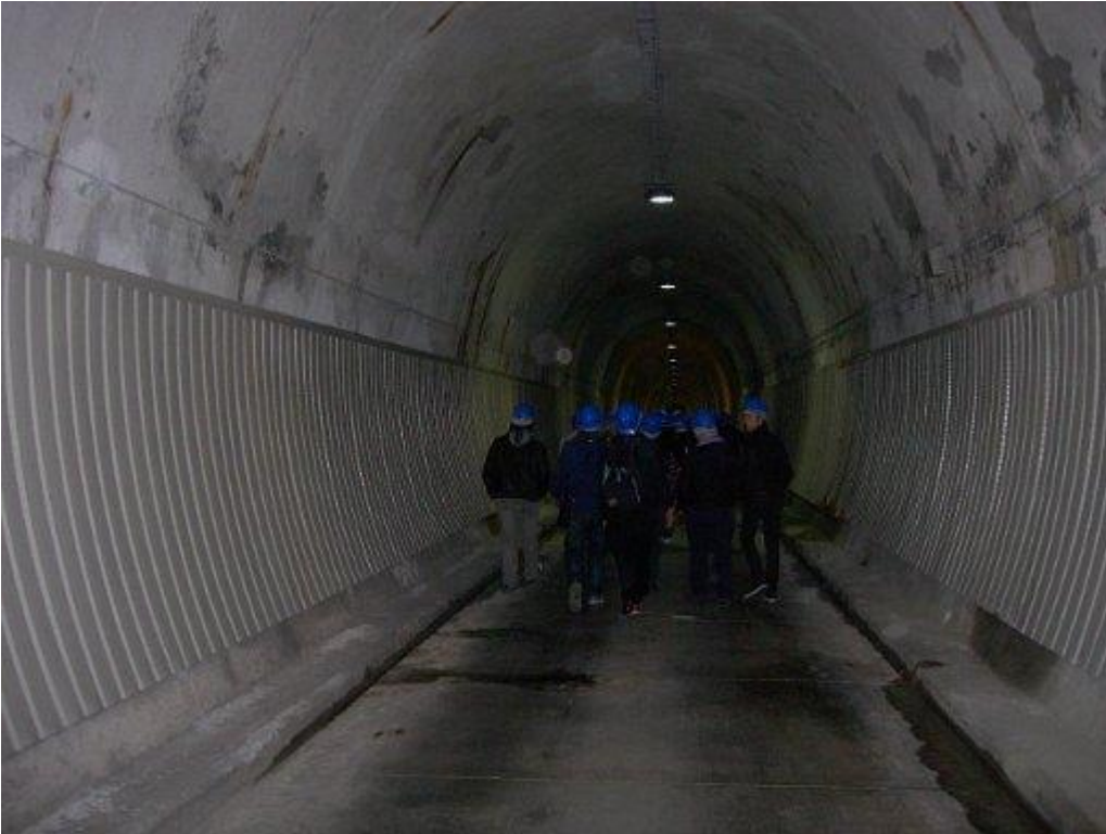
Centrale idroelettrica Mucone, (CS)
